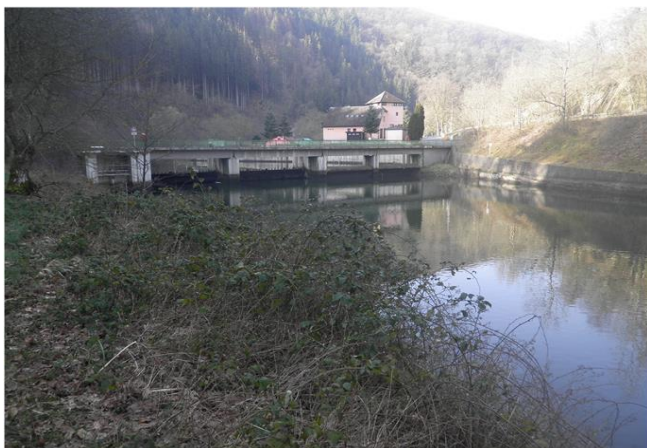
Foto gegen Fließrichtung
