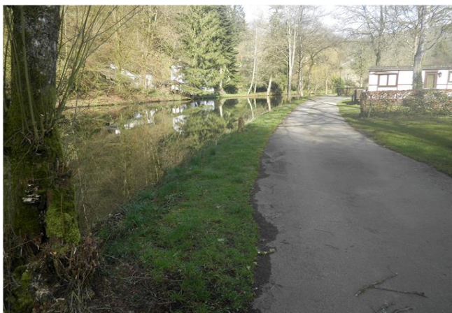
Foto gegen Fließrichtung
