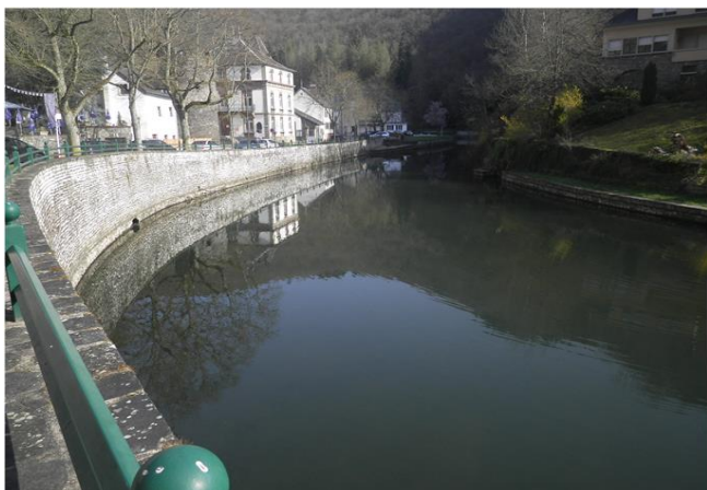
Foto gegen Fließrichtung
