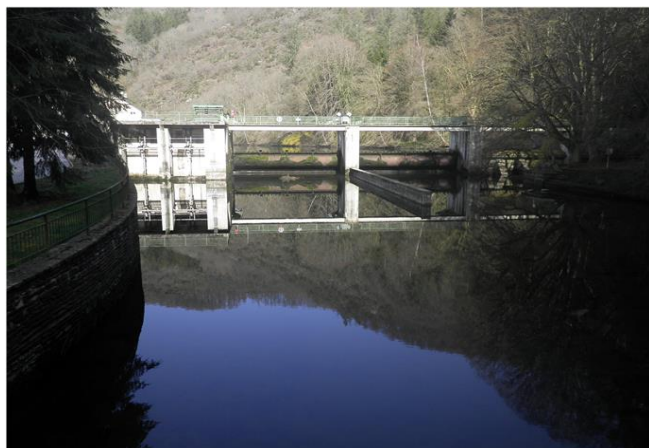
Foto gegen Fließrichtung
