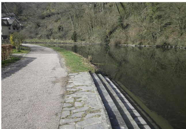
Foto gegen Fließrichtung
