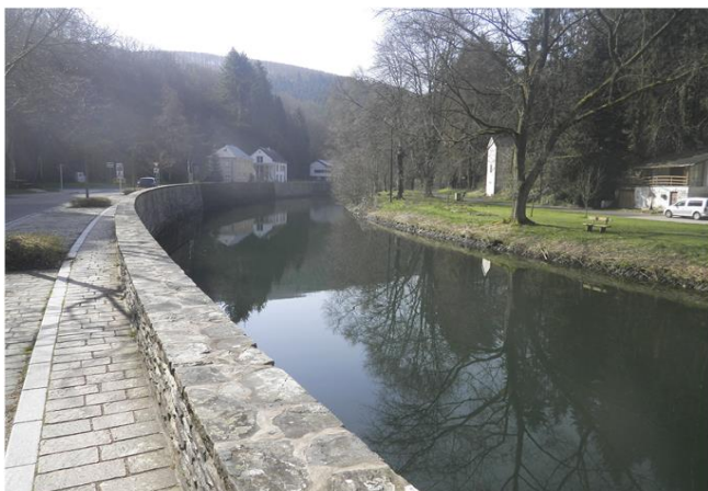
Foto gegen Fließrichtung
