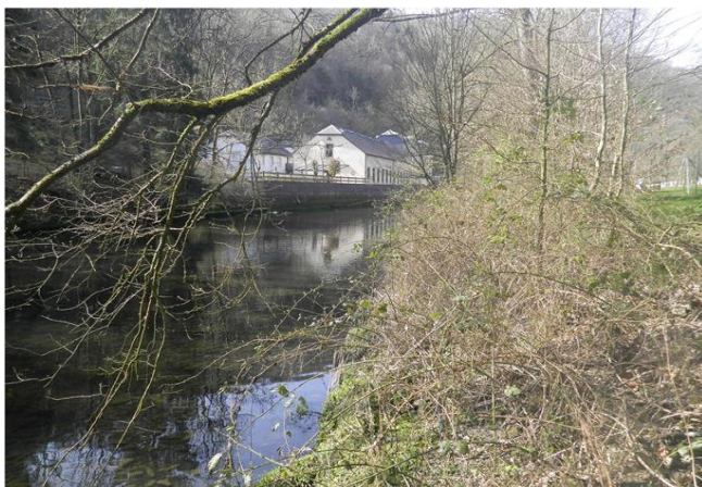
Foto gegen Fließrichtung
