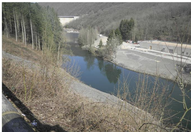
Foto gegen Fließrichtung
