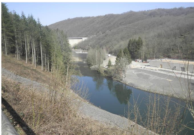
Foto gegen Fließrichtung
