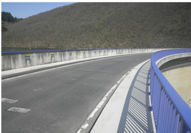
Foto gegen Fließrichtung
