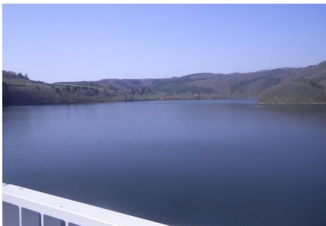
Foto gegen Fließrichtung
