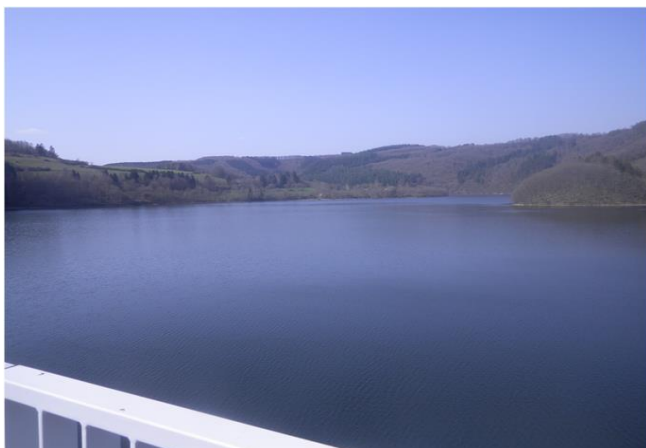
Foto gegen Fließrichtung
