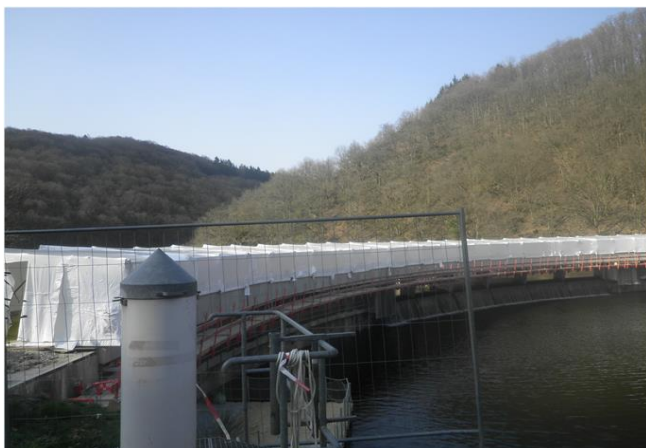
Foto gegen Fließrichtung
