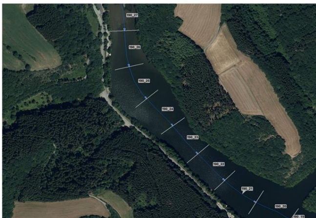
Foto gegen Fließrichtung
