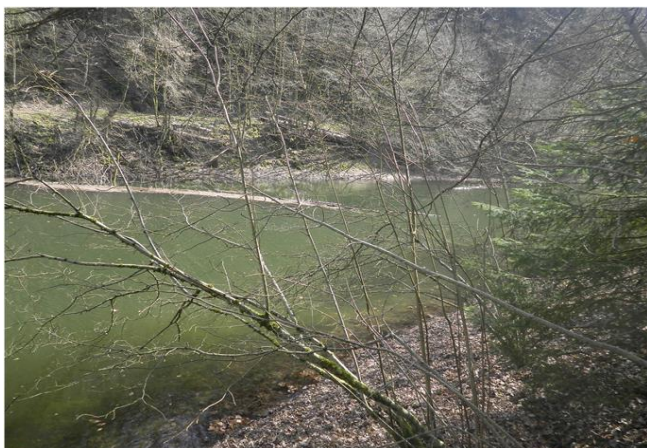
Foto gegen Fließrichtung
