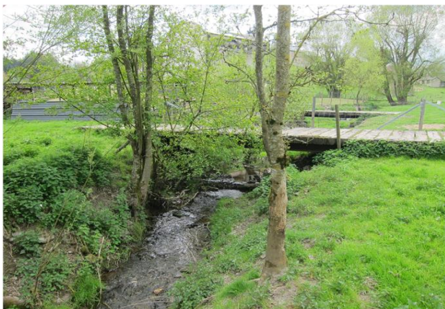
Foto gegen Fließrichtung
