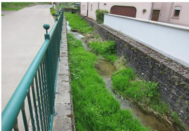
Foto gegen Fließrichtung
