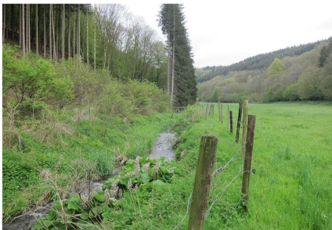
Foto gegen Fließrichtung
