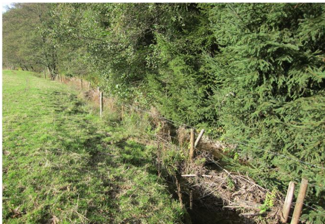
Foto gegen Fließrichtung
