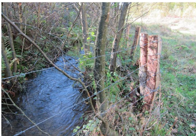
Foto gegen Fließrichtung
