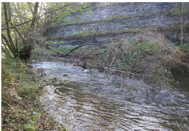
Foto gegen Fließrichtung
