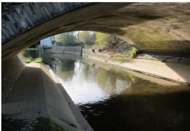
Foto gegen Fließrichtung
