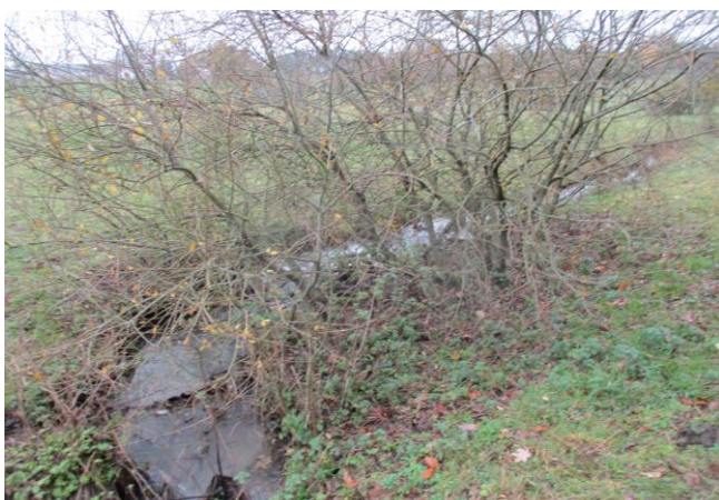
Foto gegen Fließrichtung
