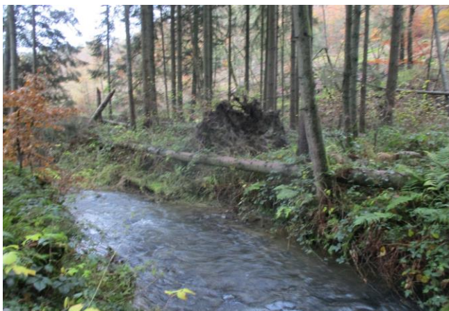
Foto gegen Fließrichtung
