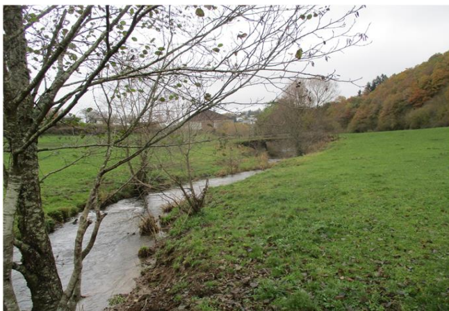
Foto gegen Fließrichtung
