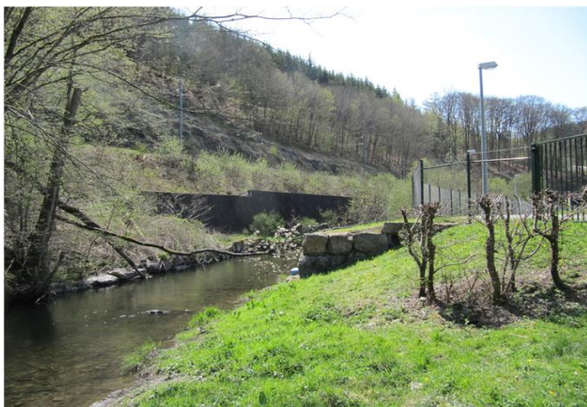
Foto gegen Fließrichtung
