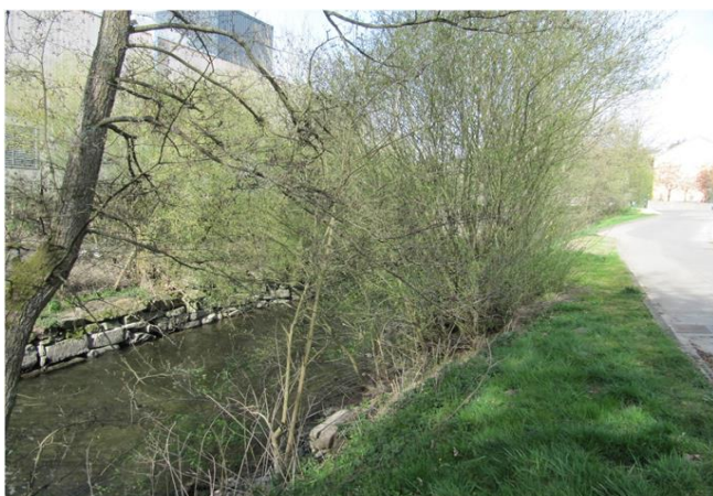
Foto gegen Fließrichtung
