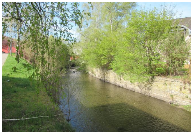
Foto gegen Fließrichtung
