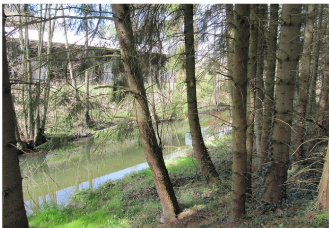
Foto gegen Fließrichtung
