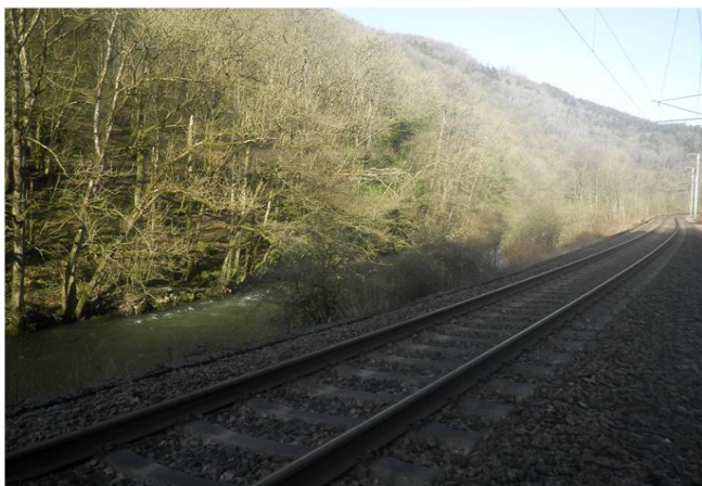
Foto gegen Fließrichtung
