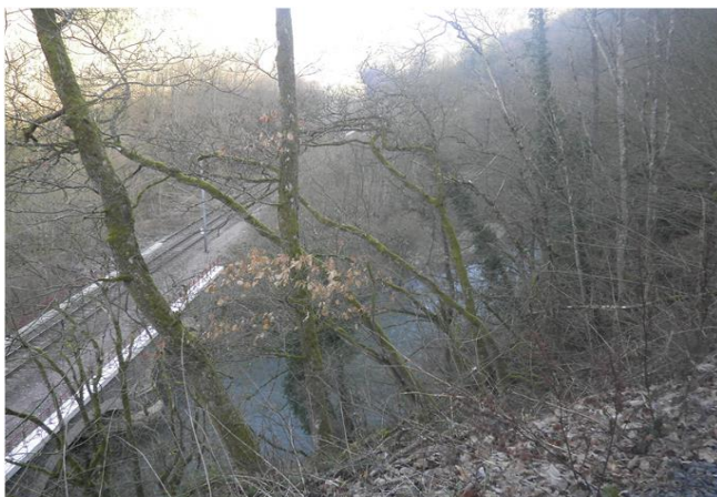
Foto gegen Fließrichtung
