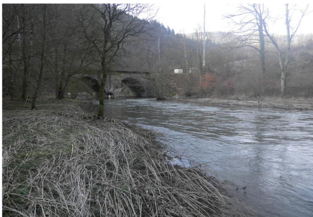
Foto gegen Fließrichtung
