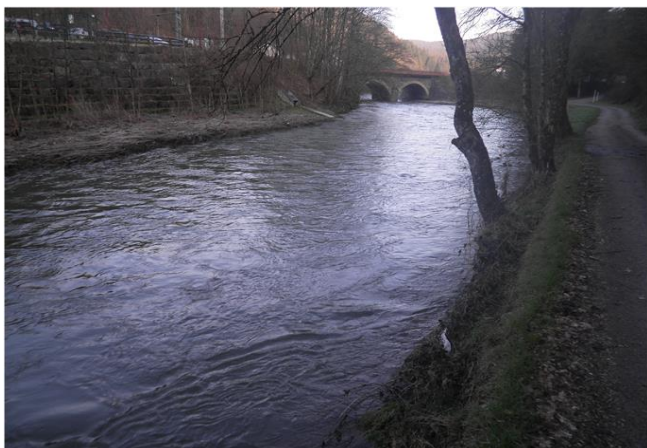
Foto gegen Fließrichtung
