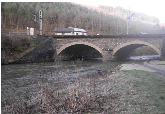
Foto gegen Fließrichtung
