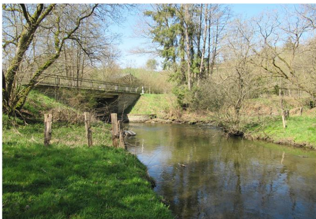
Foto gegen Fließrichtung
