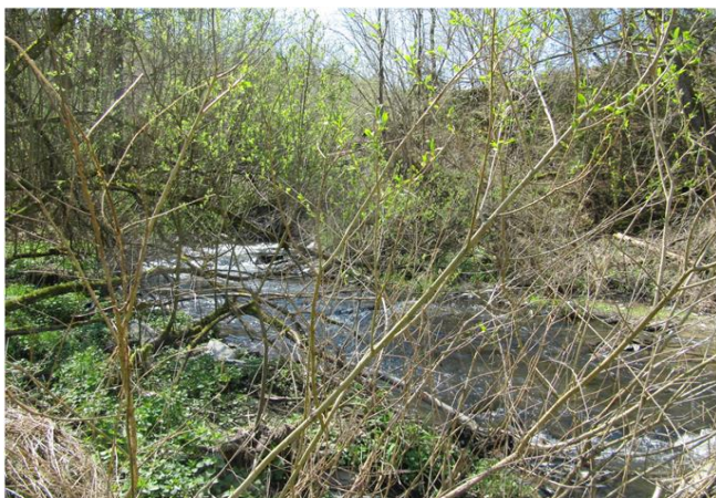
Foto gegen Fließrichtung
