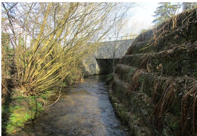
Foto gegen Fließrichtung
