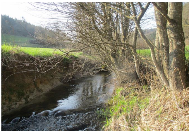
Foto gegen Fließrichtung
