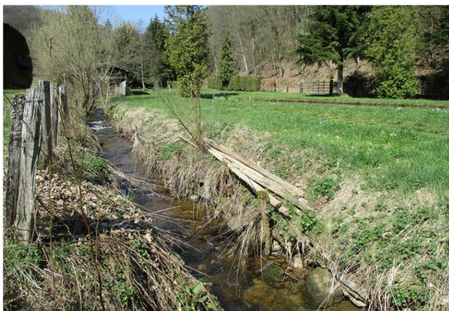
Foto gegen Fließrichtung
