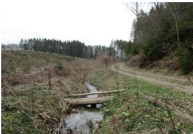
Foto gegen Fließrichtung
