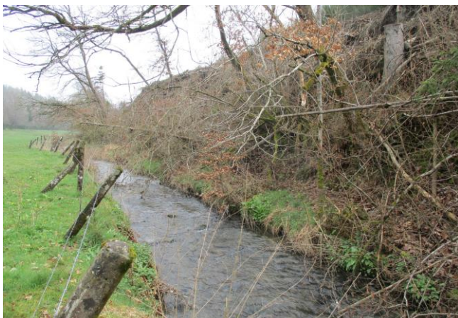
Foto gegen Fließrichtung
