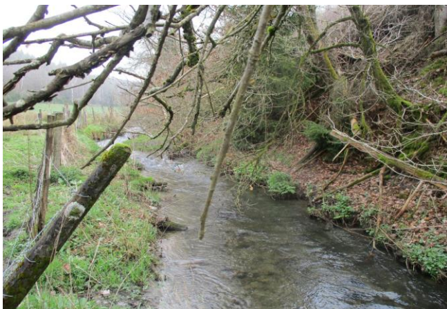
Foto gegen Fließrichtung
