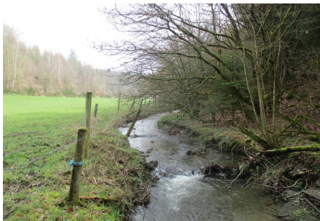
Foto gegen Fließrichtung
