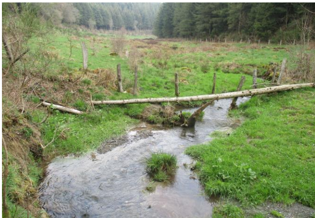
Foto gegen Fließrichtung
