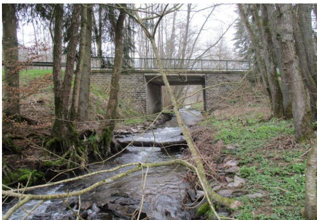
Foto gegen Fließrichtung
