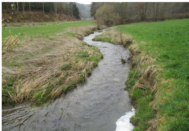
Foto gegen Fließrichtung
