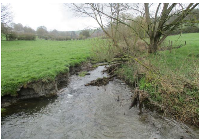
Foto gegen Fließrichtung
