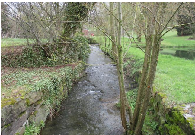
Foto gegen Fließrichtung
