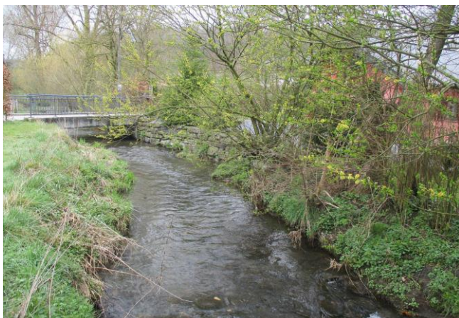
Foto gegen Fließrichtung
