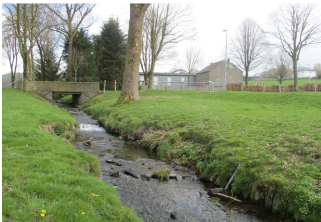
Foto gegen Fließrichtung
